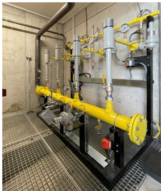
Sliki 2 in 3: 4 x 2000 kW Venturi mešalna enota na jeklenem ogrodju
